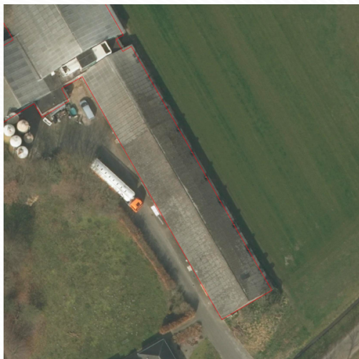
Groot – asbestverdacht (eenduidig)
