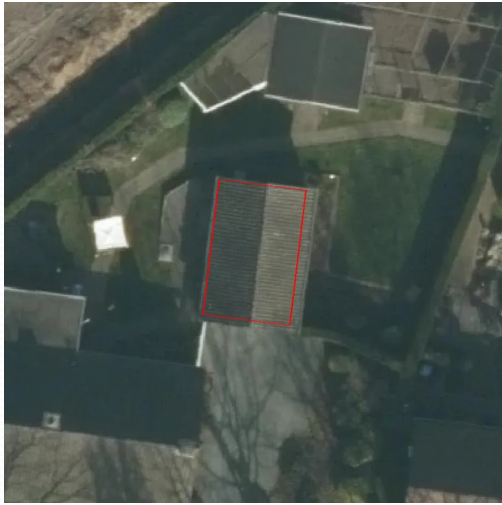
Klein – géén asbest (lijkt op golfplaat)
