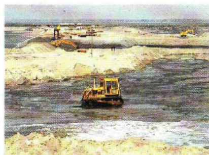
.... dat men de dammen volledig kon sluiten door het opspuiten van zand.
