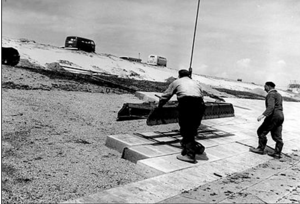
Aanbrengen bekleding met betonblokken
