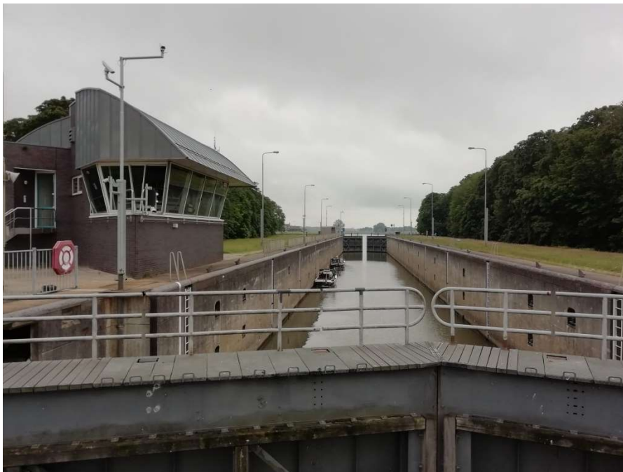
Figuur 2 - Foto overzicht schutsluis vanaf het benedenhoofd
