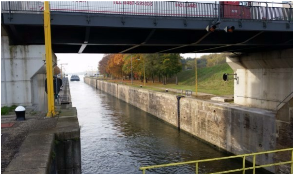
Figuur 4: Oostsluis (kijkend richting Maas-Waalkanaal)
