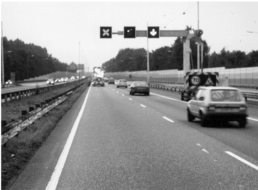
Afbeelding 119: Voorziening bij Werk in Uitvoering.
