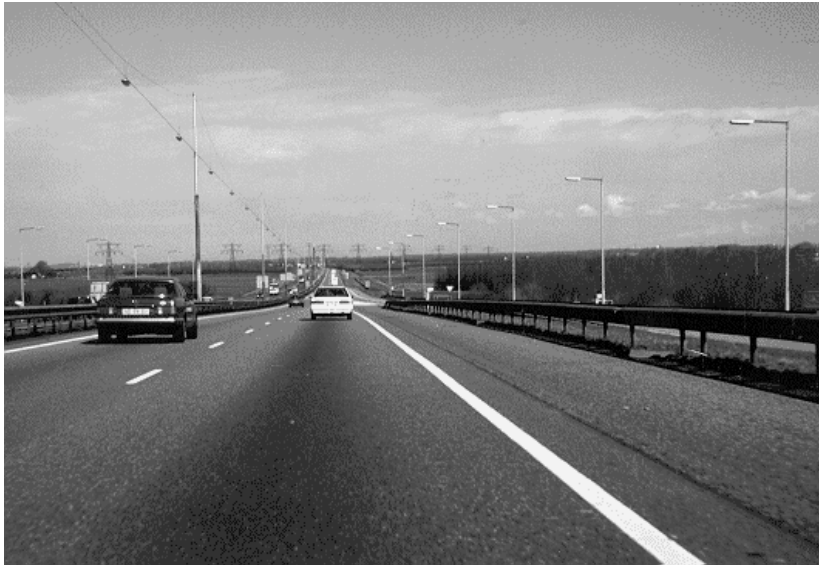
Afbeelding 138: Lijnverlichting op (hoofdrijbaan) + Mastverlichting op (verbindingsweg).
