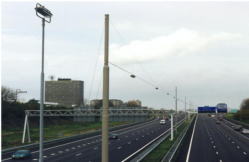
Afbeelding 136: Lijnverlichting.
