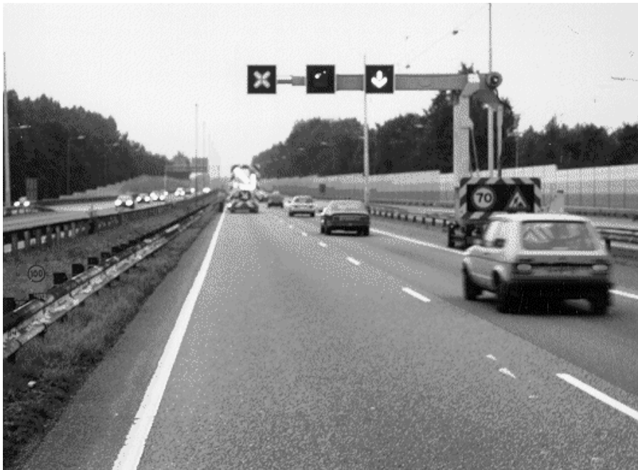
Afbeelding 125: Voorziening bij Werk in Uitvoering.
