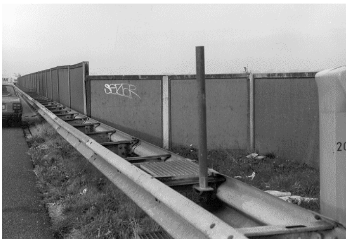
Afbeelding 36: Verandering in afstand en hoogte van geluidsscherm.
