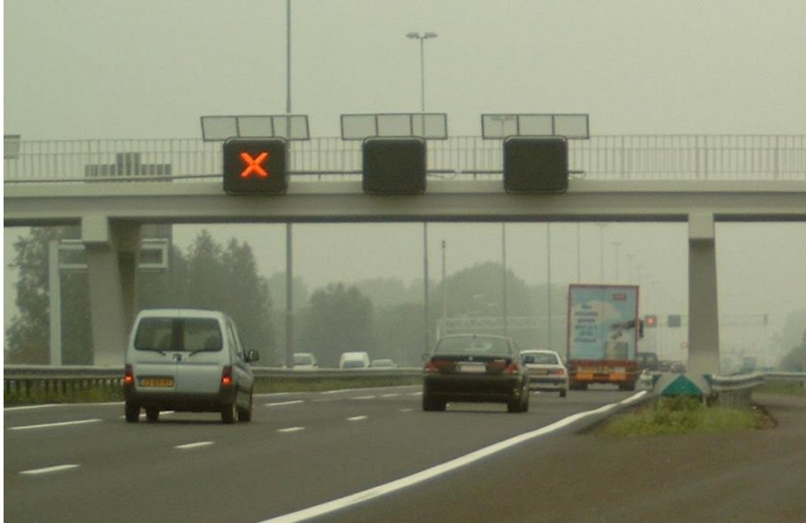
Afbeelding 120: Autosnelweg–signalering met strookafzetting
