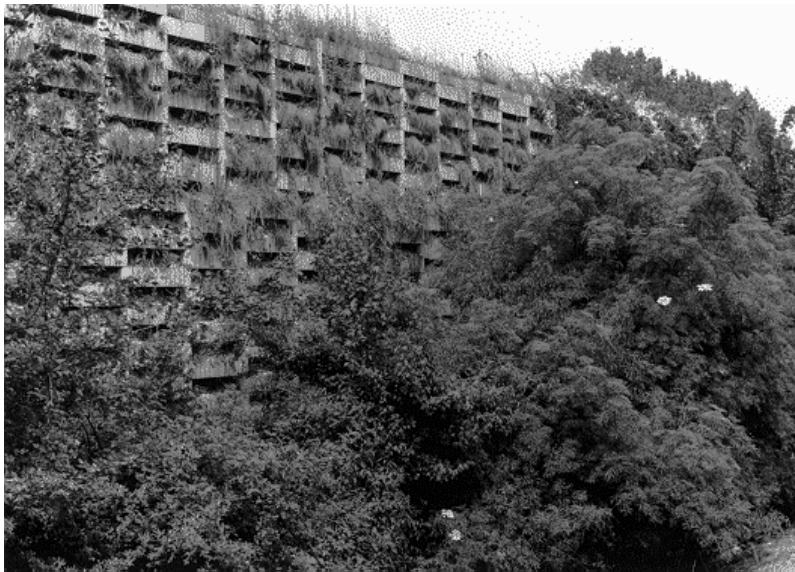
Afbeelding 28: Geluidswal als stapel constructie.
