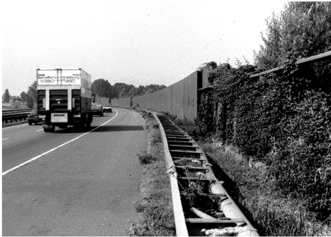
Afbeelding 35: Overgang in de soort van de geluidsscherm.
