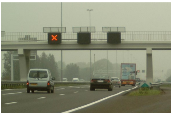
Afbeelding 126: Autosnelweg–signalering met strookafzetting
