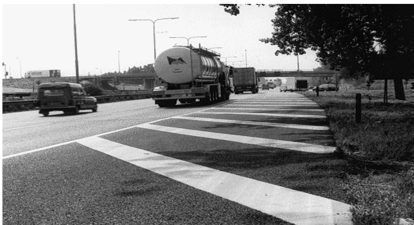
Afbeelding 51: Verdrijfstrepen op de vluchtstrook.
